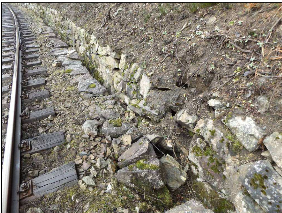
Obr. č. 9 - detailní pohled na rozvalenou část zdi, kde je poručená ZZ i zídka mezi příkopem a kolejí.
