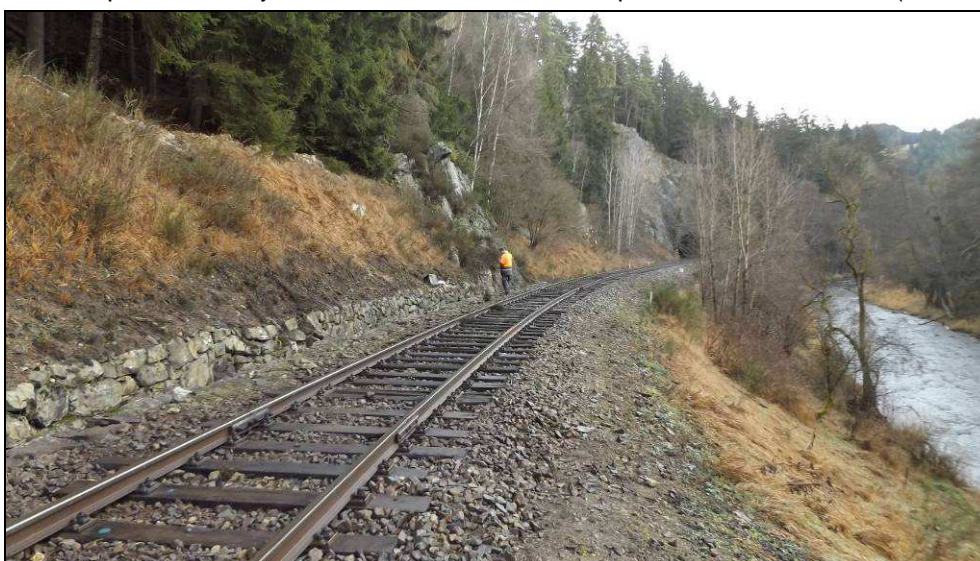
Obr. č. 3 - pohled na konec objektu, kde je zárubní zeď ukončena a v délce cca 11 m místo ní pokračuje skalní výchoz
