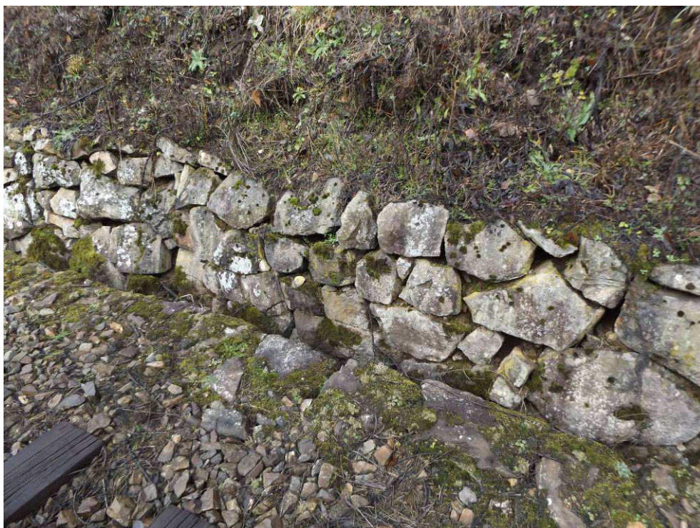
Obr. č. 8 - detailní pohled na zdivo zárubní zdi. Spáry jsou do hloubky vypadané.
