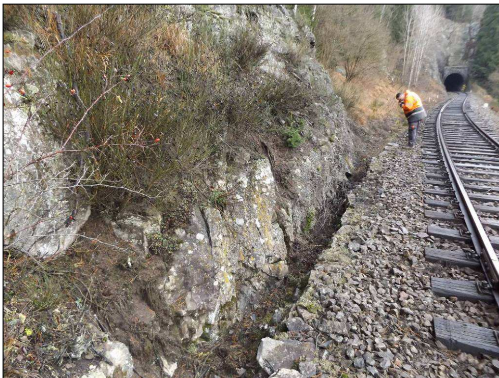
Obr. č. 4 - detailní pohled na skalní výchoz tvořící lícovou stěnu svahu a součást příkopu
