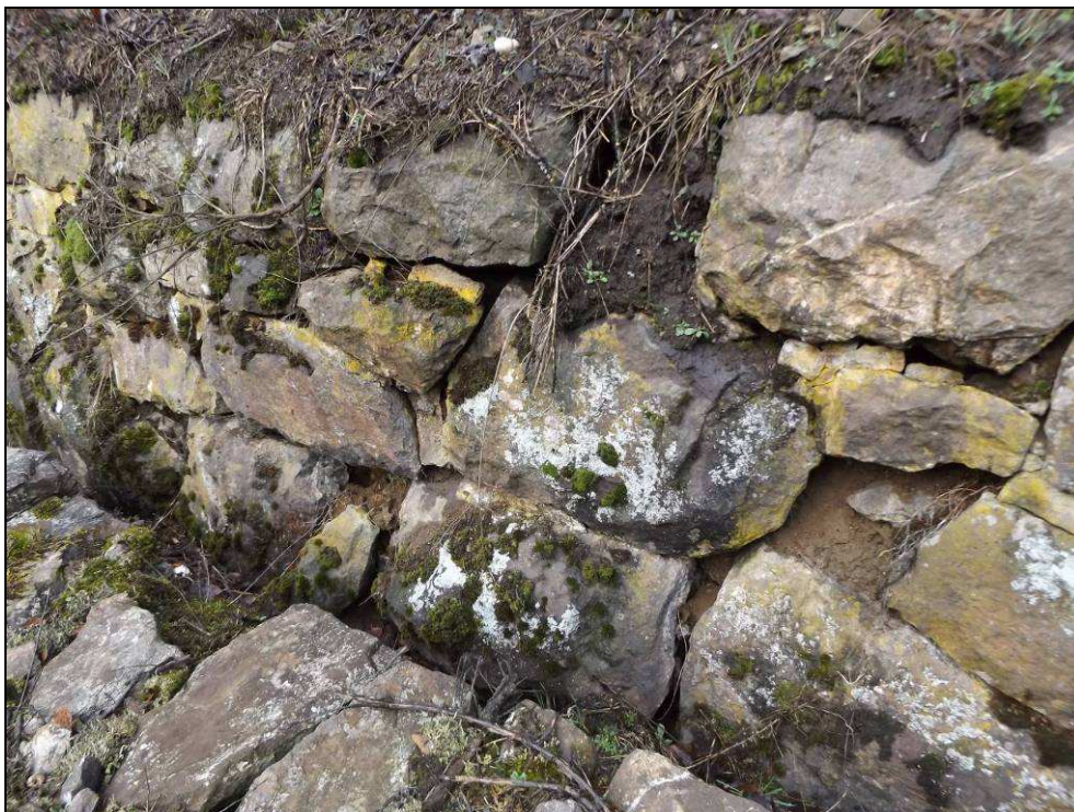
Obr. č. 7 - detailní pohled na zdivo zárubní zdi. Původně se jednalo o kamenné zdivo pojené maltou. Pojivo je dnes zcela degradované na písek a na většině plochy je vyplaveno ze spár.
