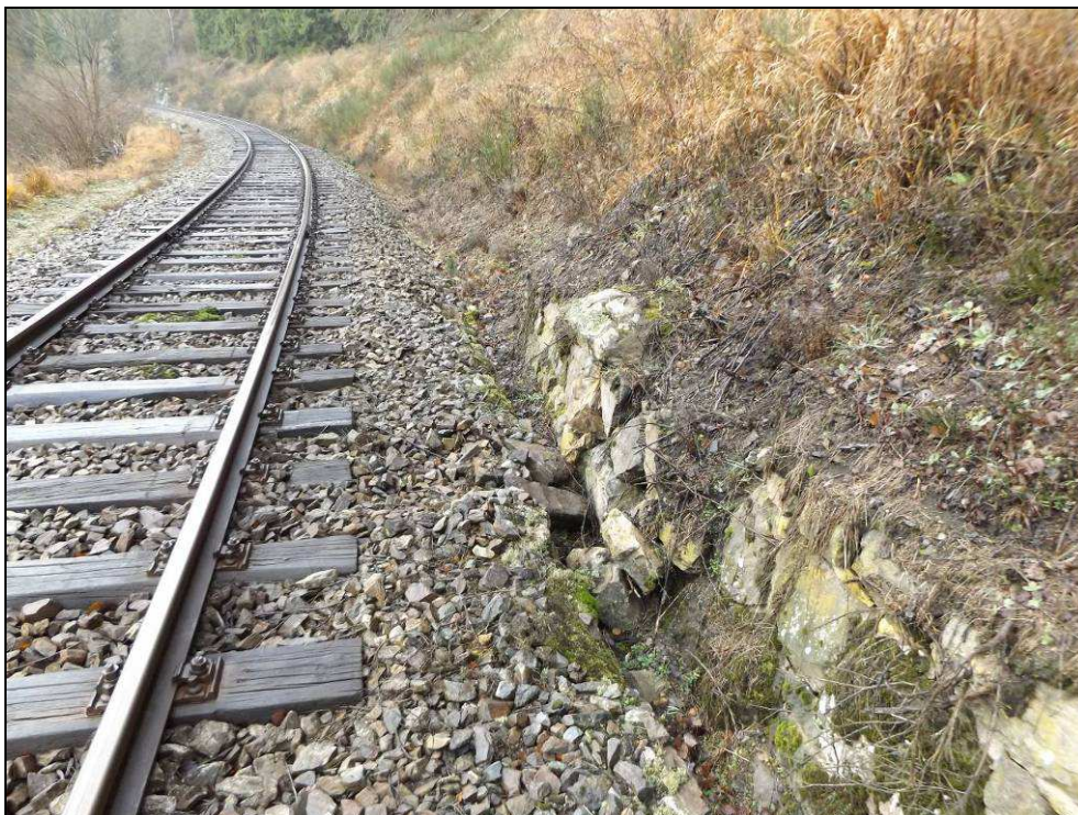
Obr. č. 6 - detailní pohled na rozvalenou zárubní zeď v km cca 29,265
